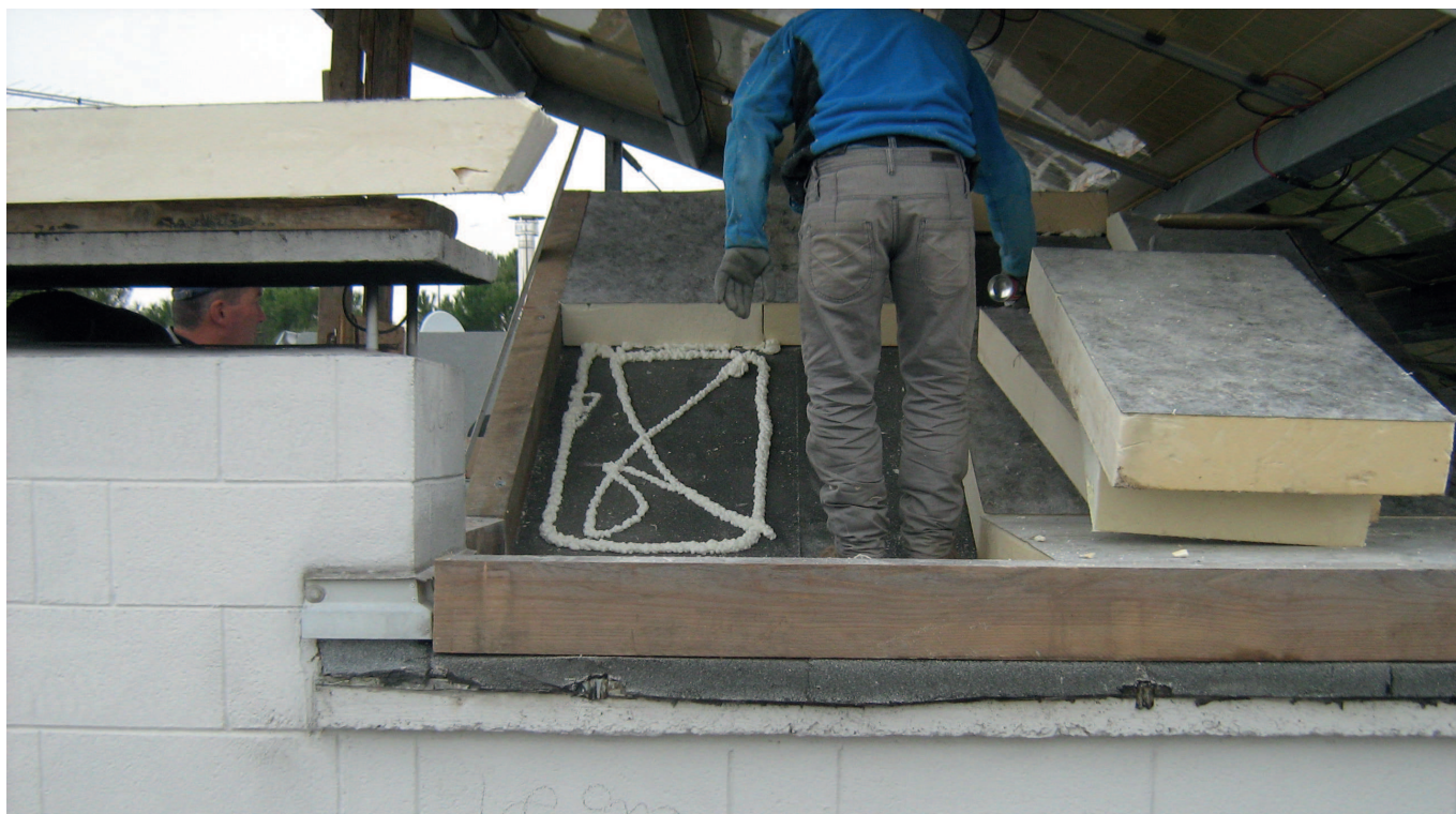
Installazione dell'isolante in copertura; in questo caso è stato utilizzato un PUR preaccoppiato con feltro pronto per l'applicazione tramite sfiammatura della guaina bituminosa.
