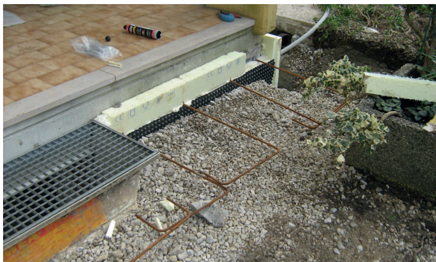
Dettaglio del rifacimento del marciapiede esterno e del taglio termico realizzato tramite l'XPS che scende ben oltre il limite del volume riscaldato per risolvere il ponte termico al piede.
