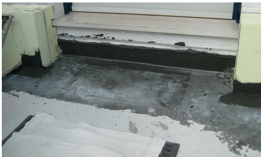
Dettaglio della porta di ingresso in una delle fasi di lavorazione con l'XPS installato e la porta preesistente - da sostituire - ancora presente.
